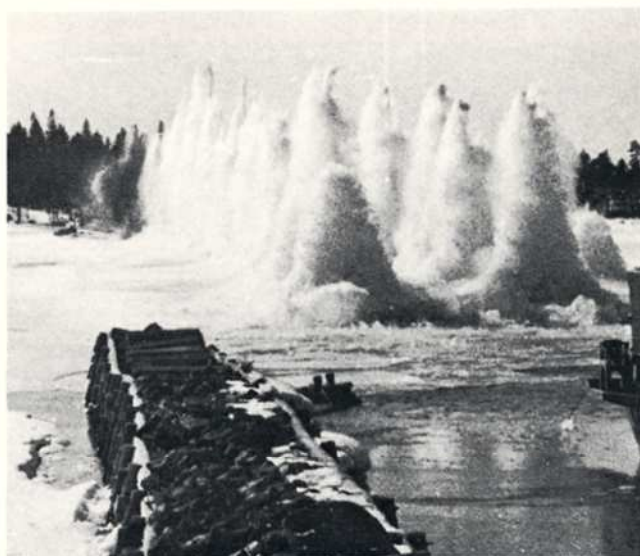
Paalasmaan lossiväylän avaus.
