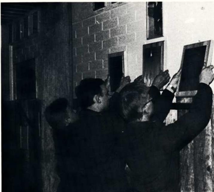
Taulujen kiinnitys Perinnehuoneen seinälle.
