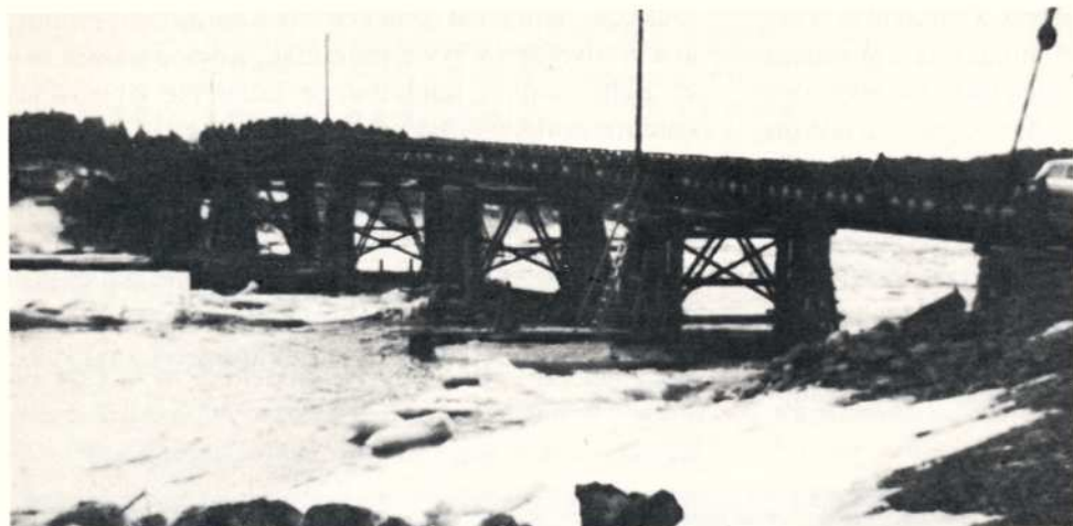
Kuurnan voimalaitoksen työmaasilta.
