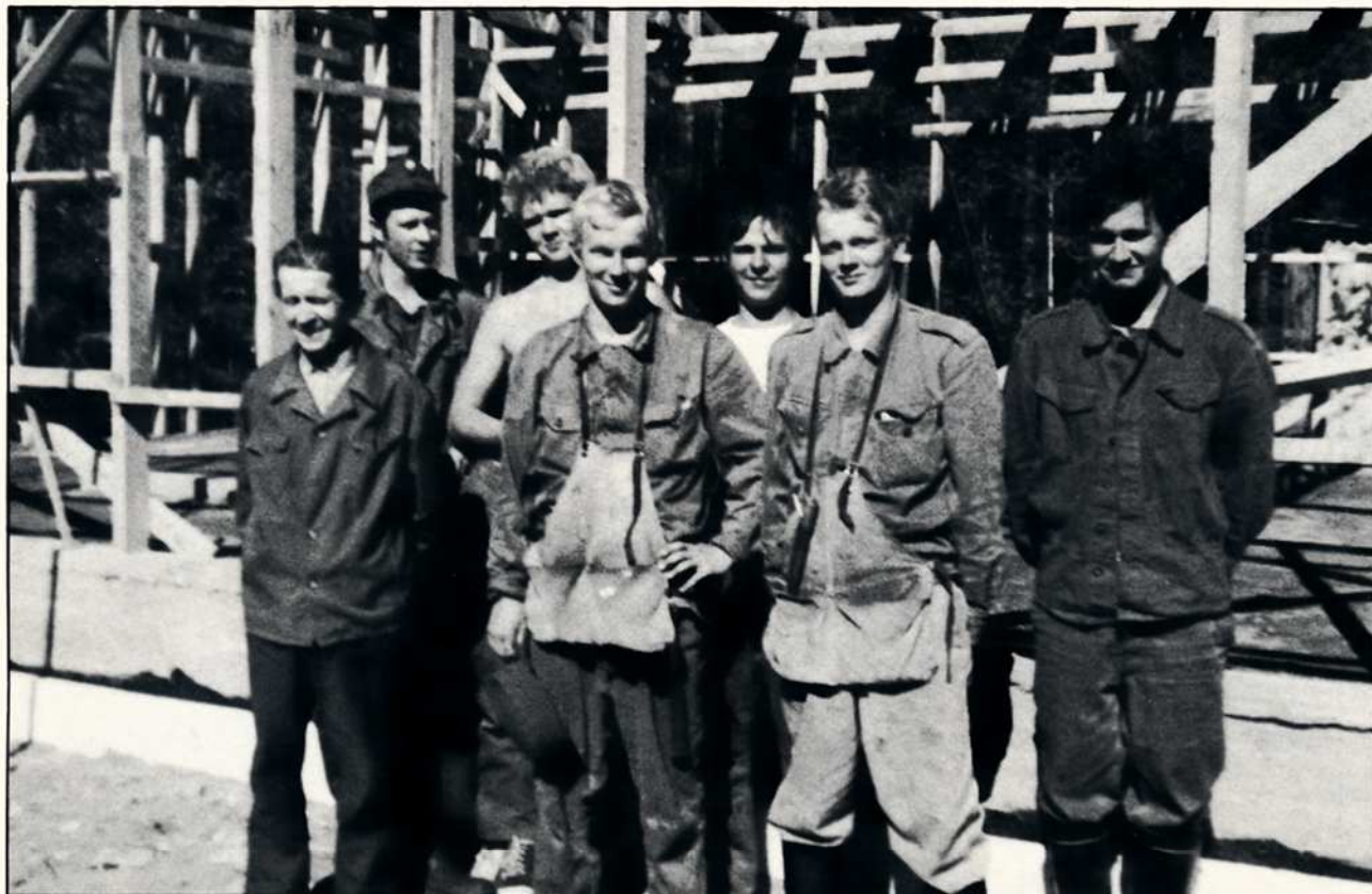
Oheisessa kuvassa talo nousuvaiheessa, isäntä ja komennuskunta. Taloon tehtiin pohja, runko, lämpöeristeet, vesikatto pellistä, tuulensuojalevy, ulkokuoraus. Varis hankki tarvikkeet Killan avustuksella. Lopputyö v 1980. Talo Kulhossa Aittolammen lähellä.
