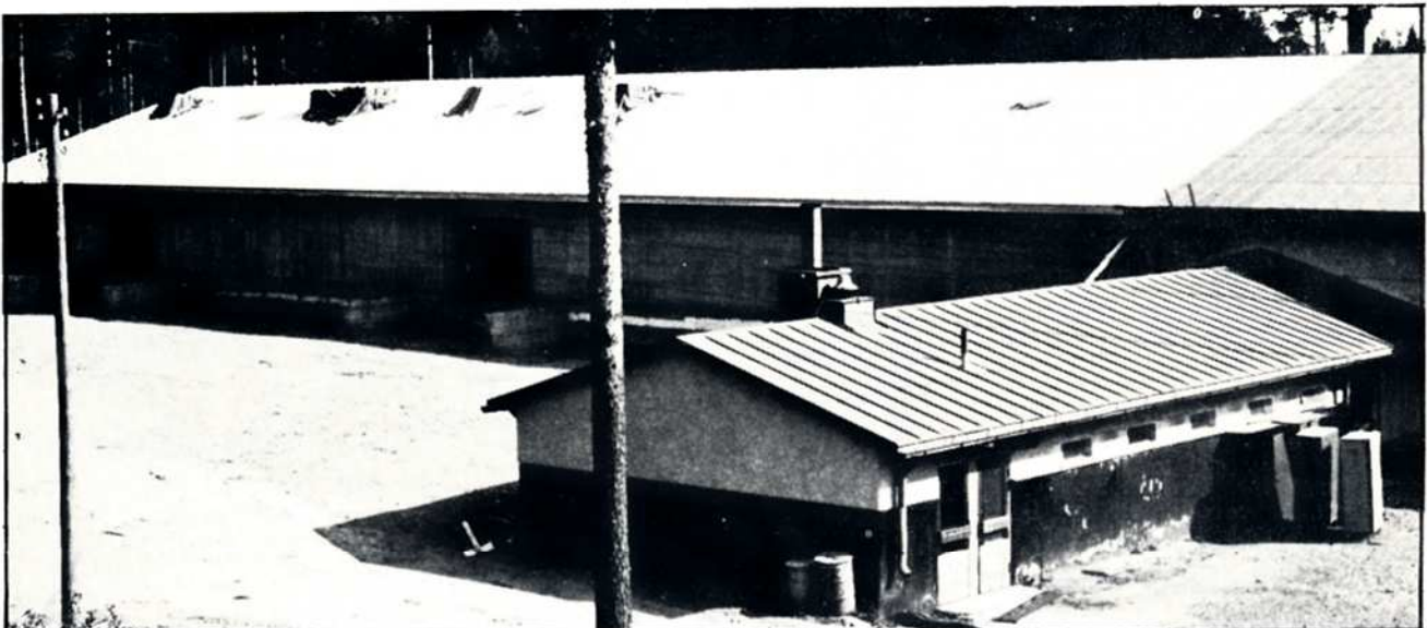
Kontiorannan varusvaraston laajennustyöt ovat olleet käynnissä syksystä 1979 alkaen. Varaston filat tulevat lisääntymään noin kaksinkertaisiksi nykyistään. Laajennusosa valmistunee keväällä 1981.
