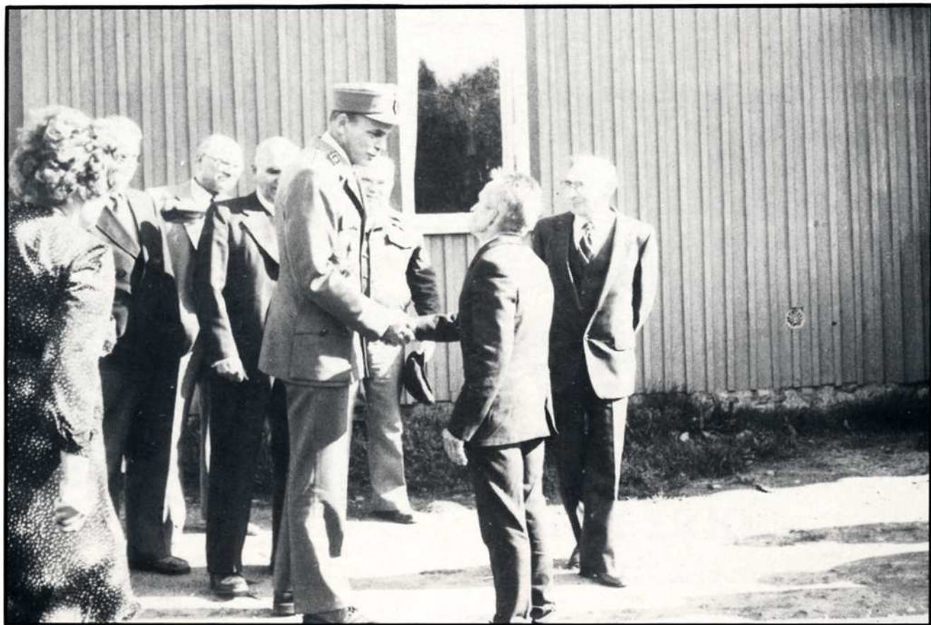
Pataljoonan komentaja everstiluutnantti Risto Koppinen tutustui JR 9 Killan syysretken yhteydessä KarJP:n varusmiesten työkohteeseen sotainvaliidi Mauno Mertasen asuinrakennuksen laajennustyömaalla Polvijärven Saarivaarassa 11. 9. 1982.
