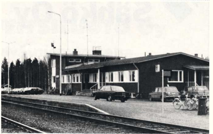
Niiralan asemarakennuksessa on kaikkiaan yhdeksän eri toimistoa VR:n, postin, tullin ja huolinnan tehtäviä varten.
