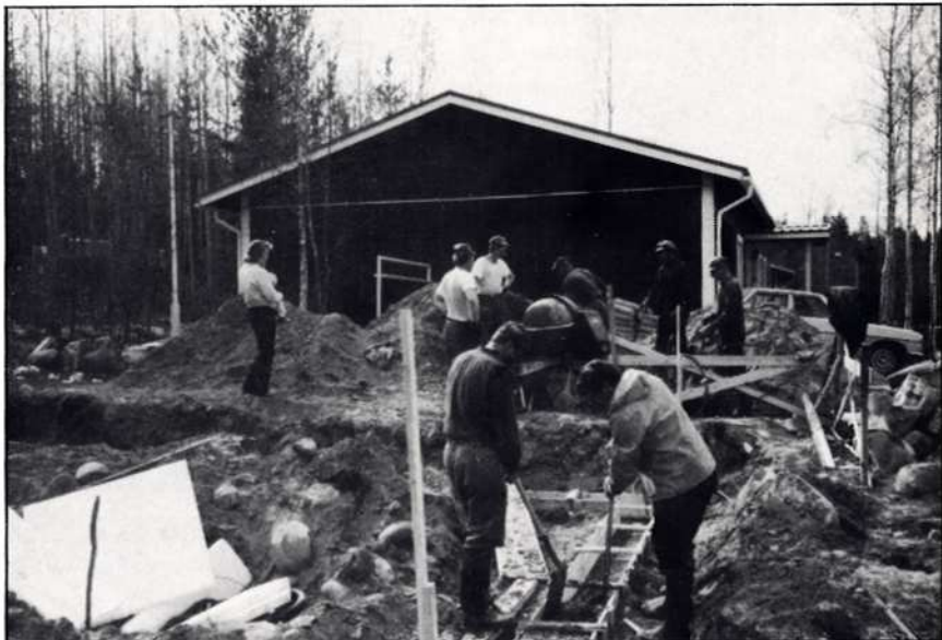
Vappuna oli anturanvalutalkoot. Sää oli lämmin ja valutyöt saatiin valmiiksi muutamassa tunnissa.
