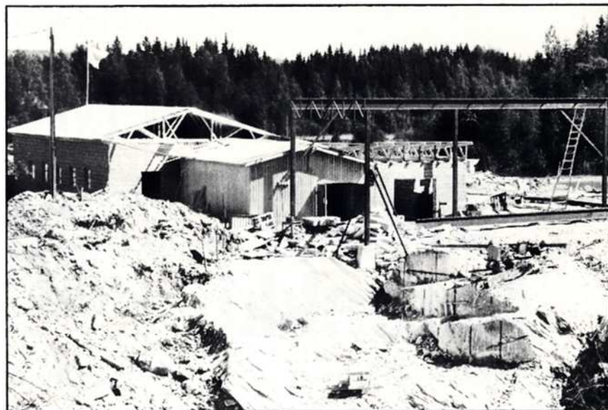
Nunnanlahden Uuni Oy:n tuotantolaitokset Juuan Nunnanlahdessa.
