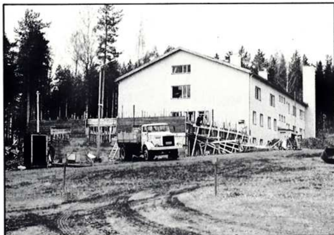
Varuskuntaa rakennetaan. Kasarmi yhden laajennustyöt käynnissä.
