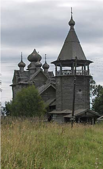
Kommunismien puhdistuksissa polttamatta jäänyt kirkko 1700-luvulta.
