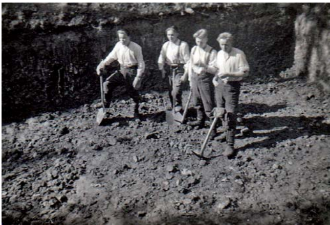
Korsun pohjan kaivajat tauolla.
